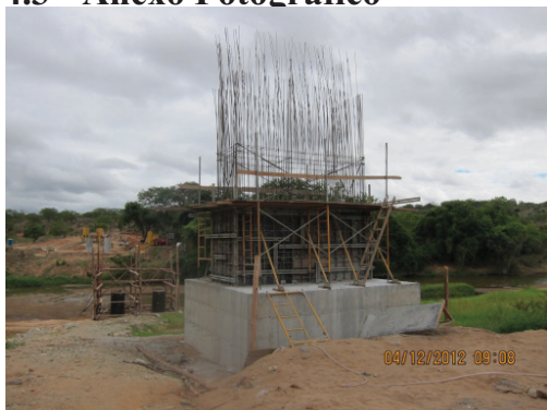
Obra de arte especial - Rio das Contas
