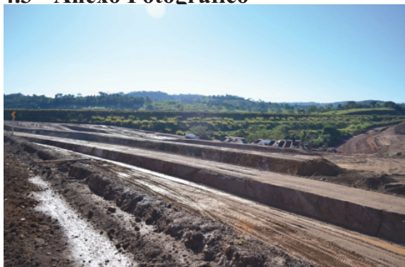
Lote 1 - encontro da Ferrovia Norte-Sul e Extensão Sul
