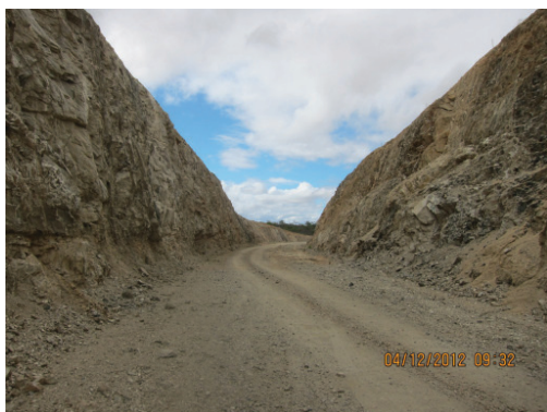
Serviços de terraplenagem.
