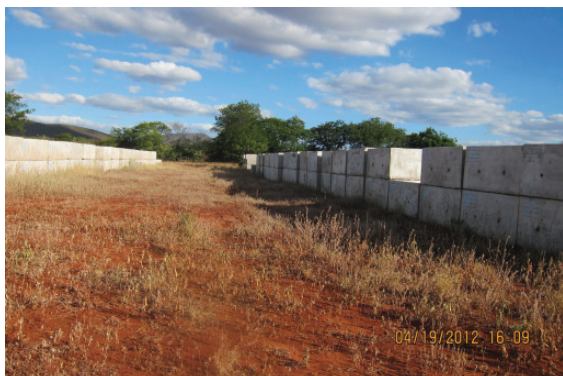
Fabricação de aduelas.
