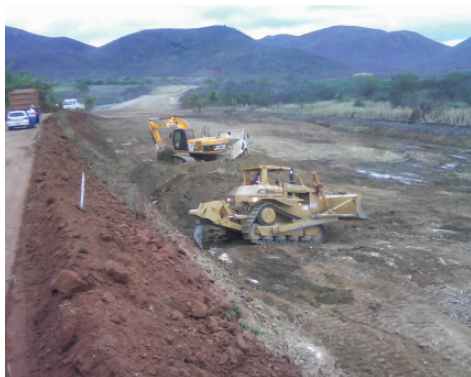
corte em material de 2ª categoria (detalhe do uso do ripper)
