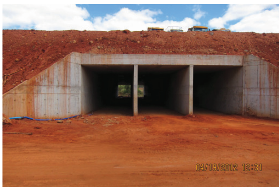
Obras de artes correntes.
