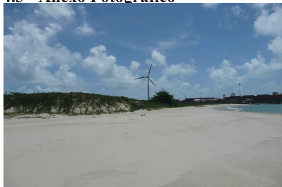
Local da construção do cais
