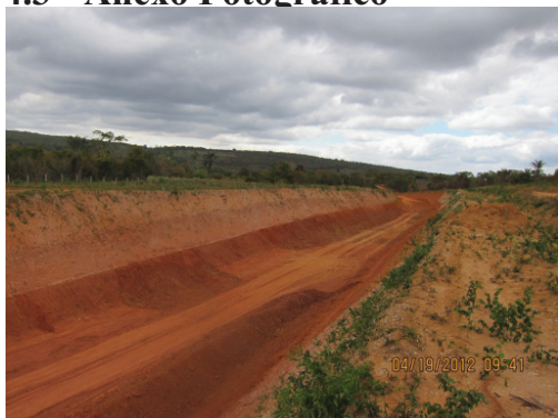
Serviços de terraplenagem.
