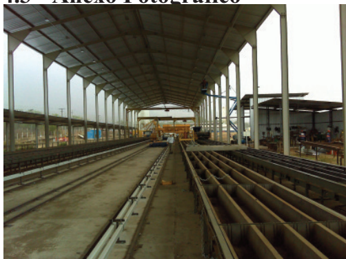
fábrica de dormentes montada no canteiro industrial do lote 2F
