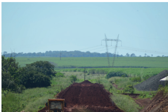
Terraplanagem e rede elétrica
