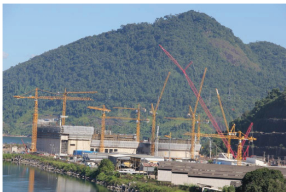
Vista geral da obra a partir de Angra 2.
