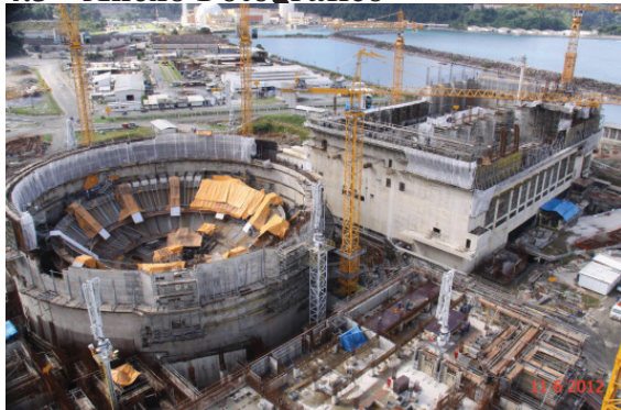
Vista aérea do prédio do reator e do prédio da turbina.
