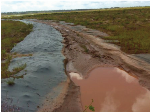
Área 2 - canal de drenagem provisório coberto com lona plástica
