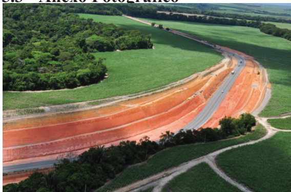
Vista aérea das obras nos lotes 4 e 5
