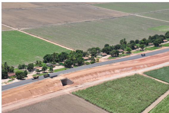
Vista aérea das obras nos lotes 4 e 5
