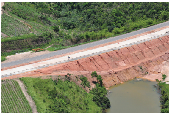
Vista aérea das obras nos lotes 4 e 5
