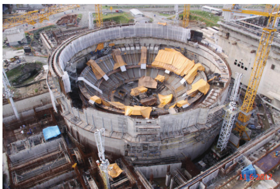
Vista aérea da montagem da esfera de contenção.
