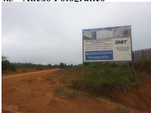
Placa de identificação da obra
