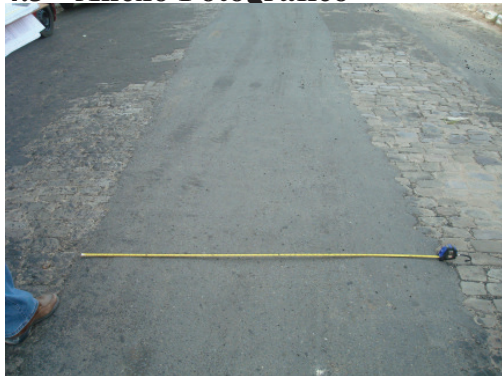
Teste de medição da largura da recomposição do pavimento referente à vala de escavação - Foto 1
