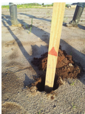
Comperj - Colchão de areia executado
