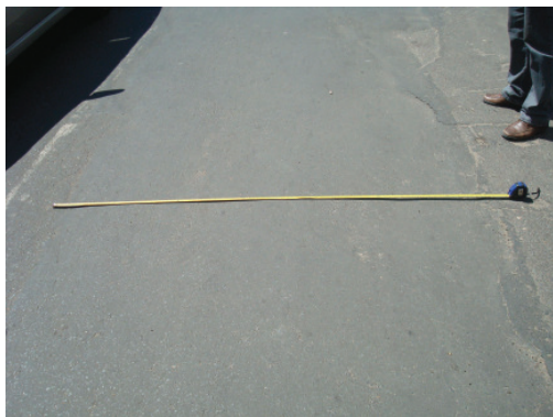
Teste de medição da largura da recomposição do pavimento referente à vala de escavação - Foto 2
