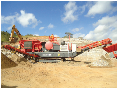
Foto 2 - Central de Britagem e jazida de exploração de brita ao fundo.
