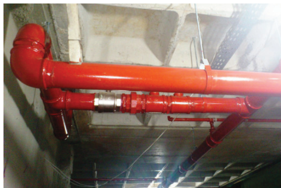
Foto das obras da 2ª Etapa: Instalações internas
