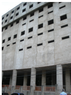
Foto das obras da 2ª Etapa: Fachada do Edifício
