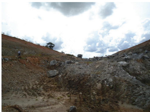
Trecho do "cortão" no km 84 - Lote 2
