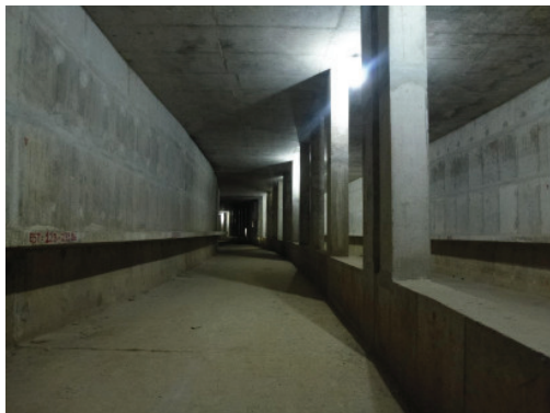
Túnel próximo à Estação Chico da Silva - Trecho correspondente ao Contrato 11/2010
