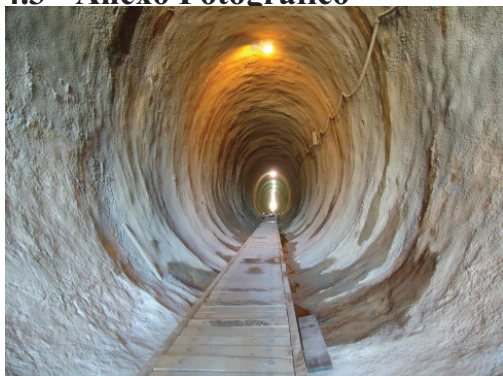
Interior do Túnel 02 no Lote 1 - Anápolis/GO
