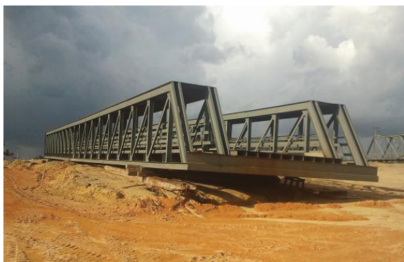
Ponte de acesso do Porto de Barcelos, atualmente localizada no estaleiro, em Manaus.
