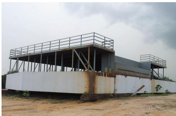
Flutuante Principal do porto de Barcelos, no estaleiro em Manaus.
