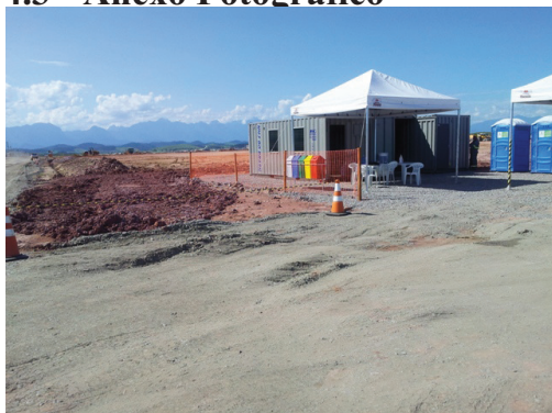
Instalações encontradas na área destinada ao canteiro principal em abril de 2012
