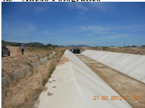
Trecho 1 - Canal trapezoidal e vista de passagem sob rodovia.
