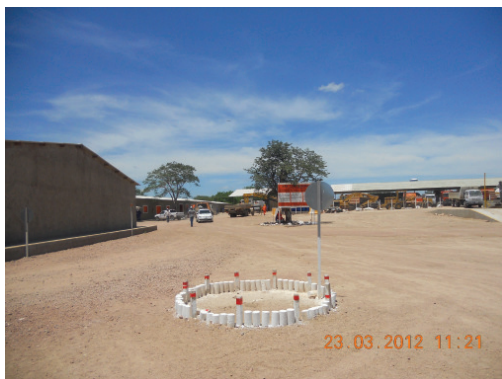
Trecho 2 - Canteiro de obras.
