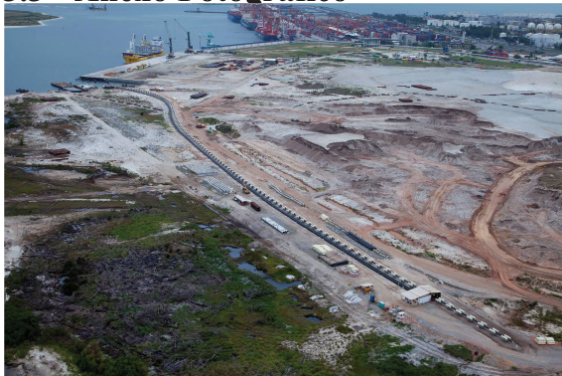
Lançamento de emissário submarino (construção e montagem dos dutos).
