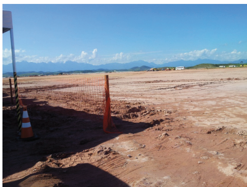
Área destinada ao canteiro principal.
