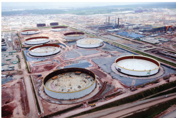
Montagem dos tanques (lote 1).
