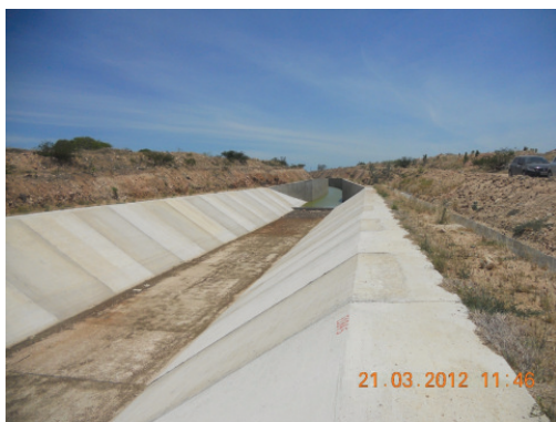
Trecho 1 - Canal trapezoidal e transição para canal retangular.
