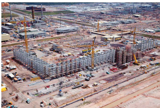
Construção e montagem da unidade de coqueamento retardado (contrato UCR).
