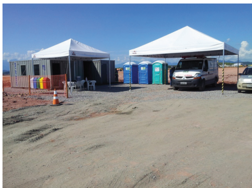
Visão geral das instalações do canteiro em abril de 2012.
